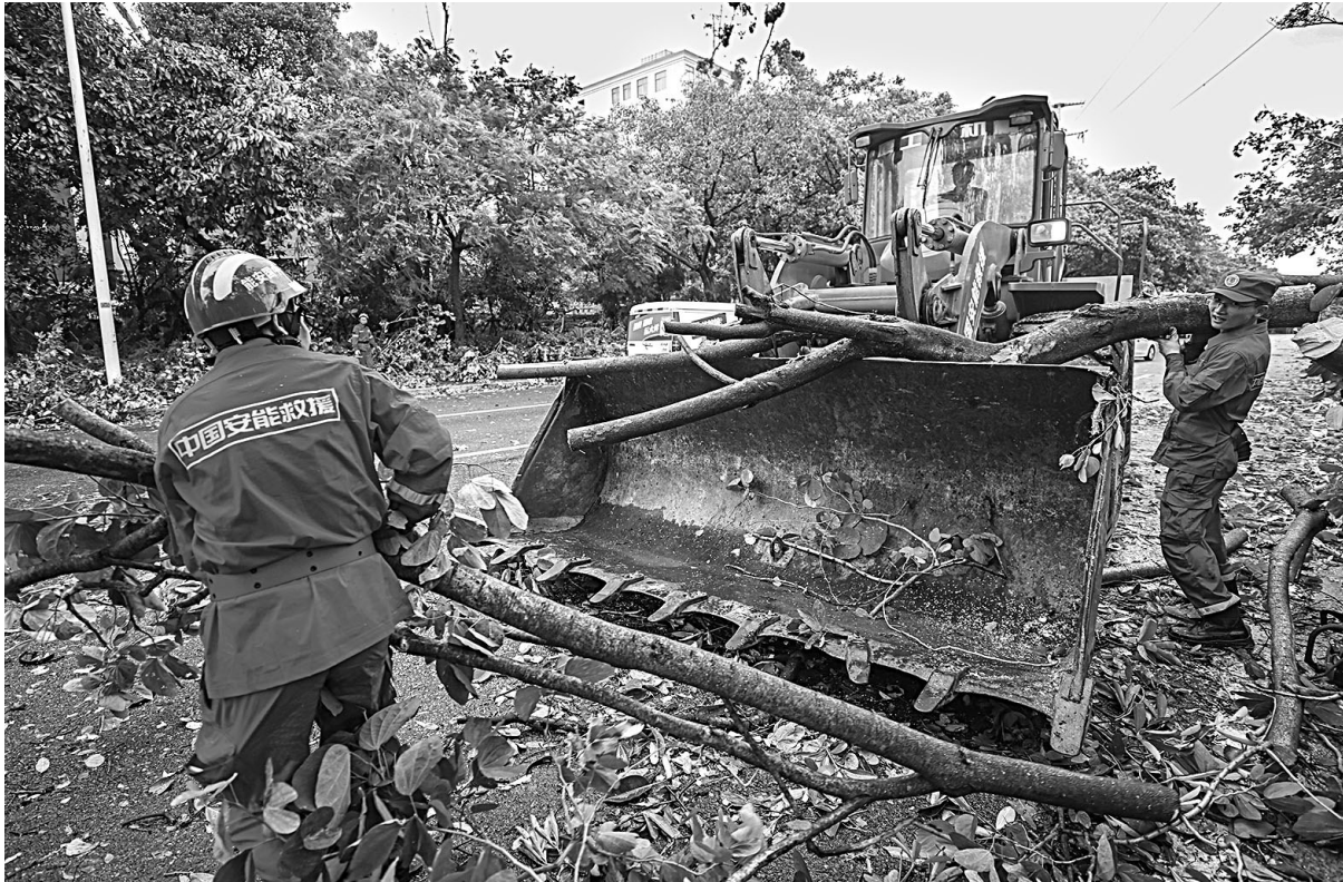
晋兴路上,中国安能专业救援队全力清理路面倾倒的绿化树。
