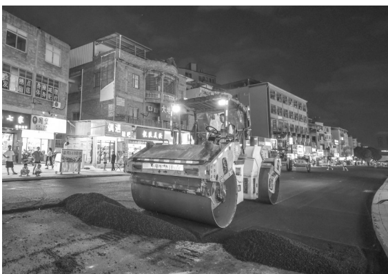
施工人員加緊攤鋪瀝青。
