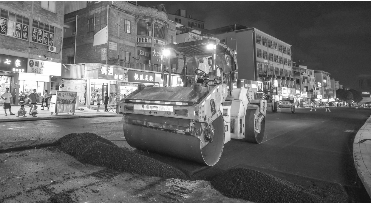
施工人员加紧摊铺沥青。
