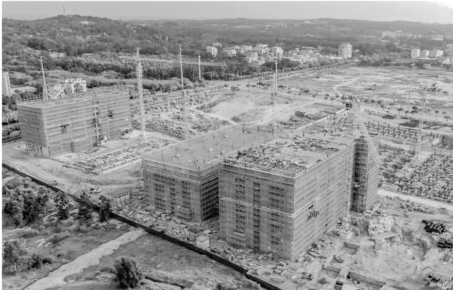
金井绿色新材料产业园项目建设现场。
