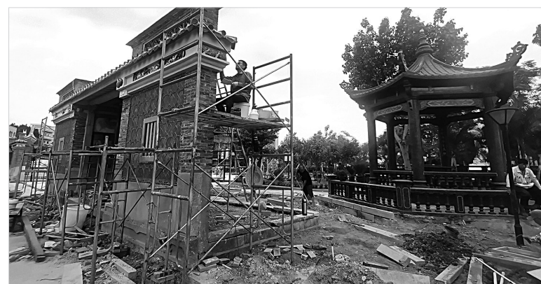
“古厝大門”施工現場。
