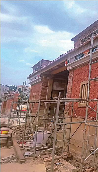
“古厝大门”施工现场。
