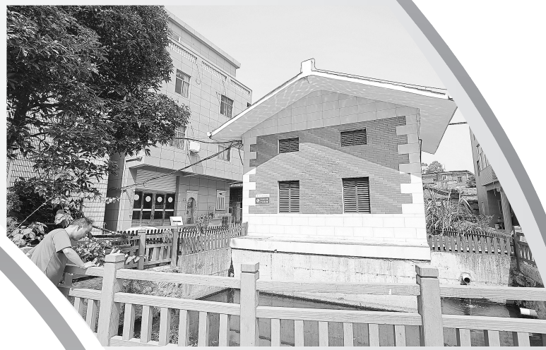
农村小型污水处理站。
