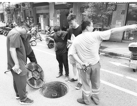
金沙城小区周边污水管网专项排查。
