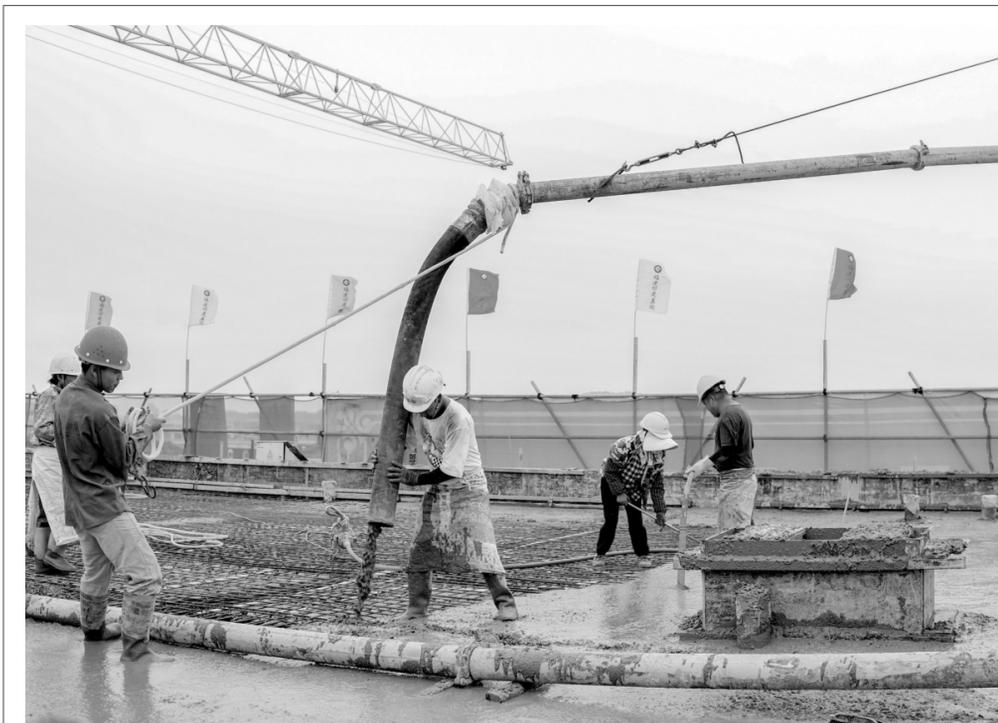
建築工人正在進行封頂澆築。
