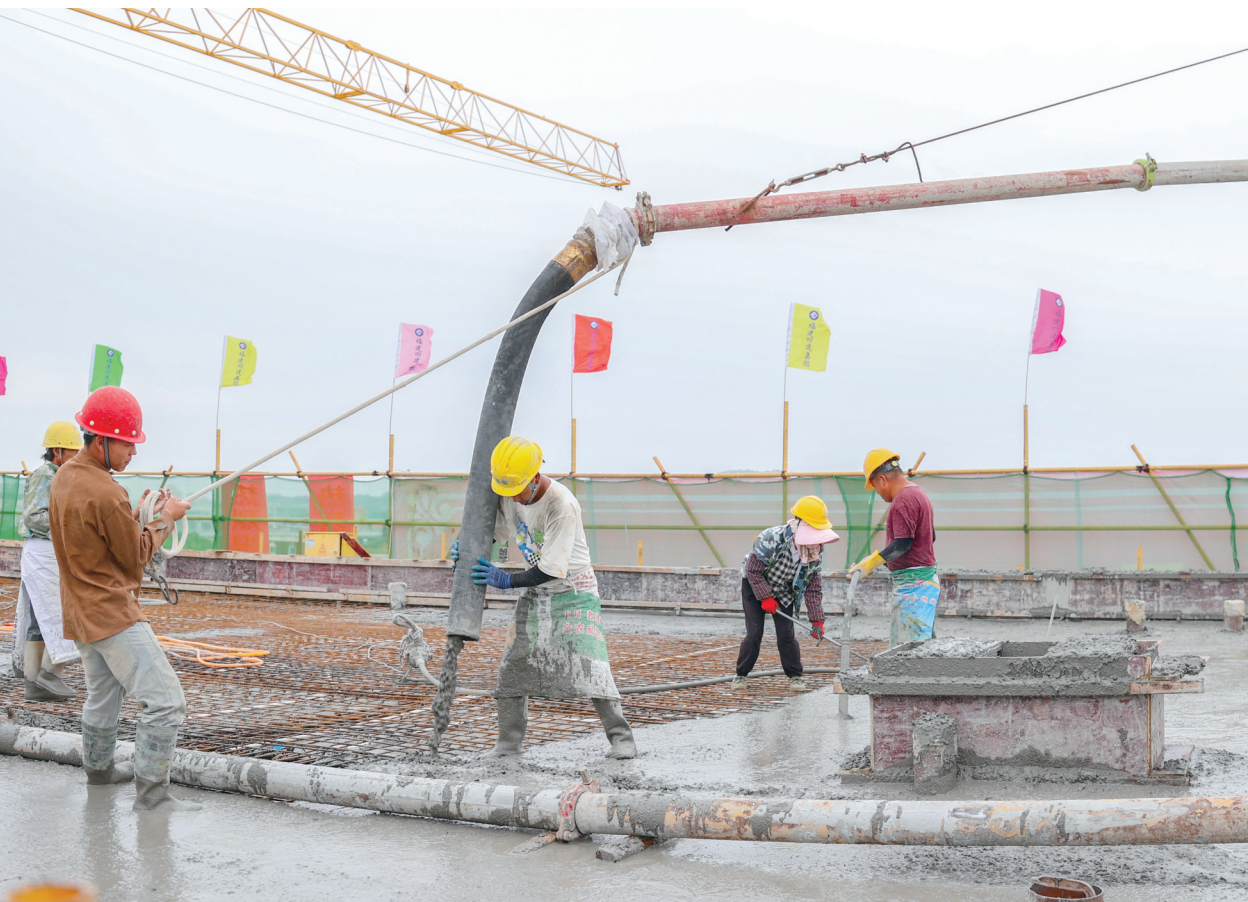
建筑工人正在进行封顶浇筑。
