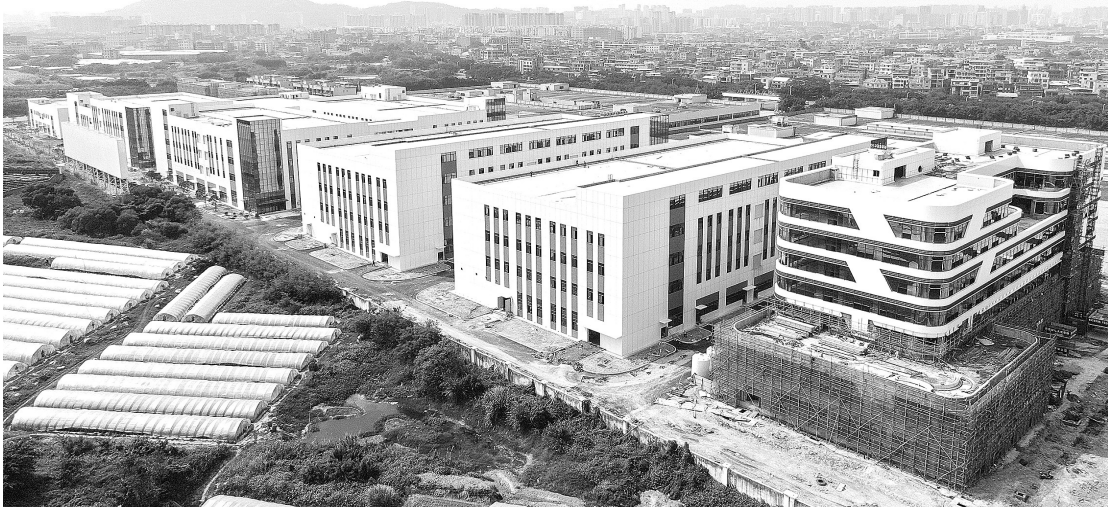
集成电路小微工业园一期项目。
