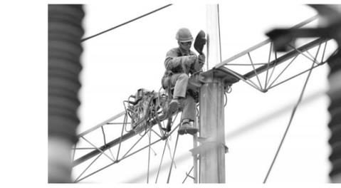
本报讯(记者 张华玲 通讯员 蔡宜航 游劲松 黄玉娥) 日前,国网晋江市供电公司运检部变电检修中心工作人员对110千伏安海变110千伏#1、#2构架避雷针进行拆除,并将新避雷针安装到位,消除安全隐患排查中发现的问题,提高变电站防雷水平,为雷雨季电网安全运行打下坚实基础。
