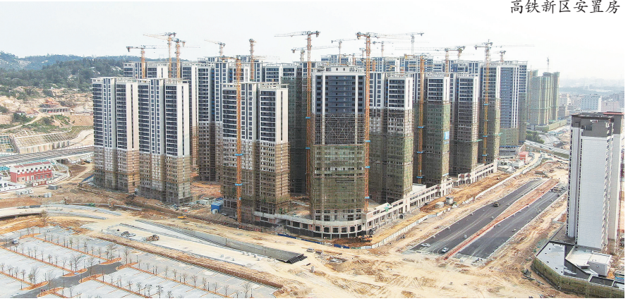
高铁新区安置房
