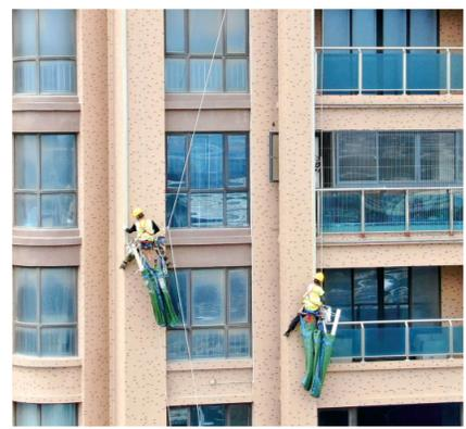
本报讯(记者 朱艳 秦越) 昨日,25名“蜘蛛人”空降晋江,忙着在百信·御江帝景等楼盘的外立面安装灯底槽、外立面电电缆线和灯盖板。作为晋江南岸照明提升工程的最后环节,待他们半个月后完工时,长5000米、高80米、超40万平方米的立面灯光秀将在晋江南岸惊艳亮相。
