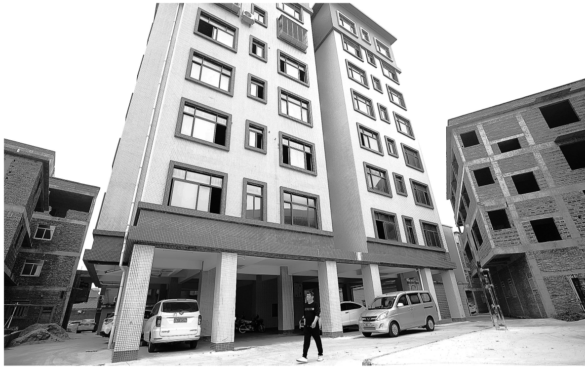
上垵村旧村改造项目3号楼建成。
