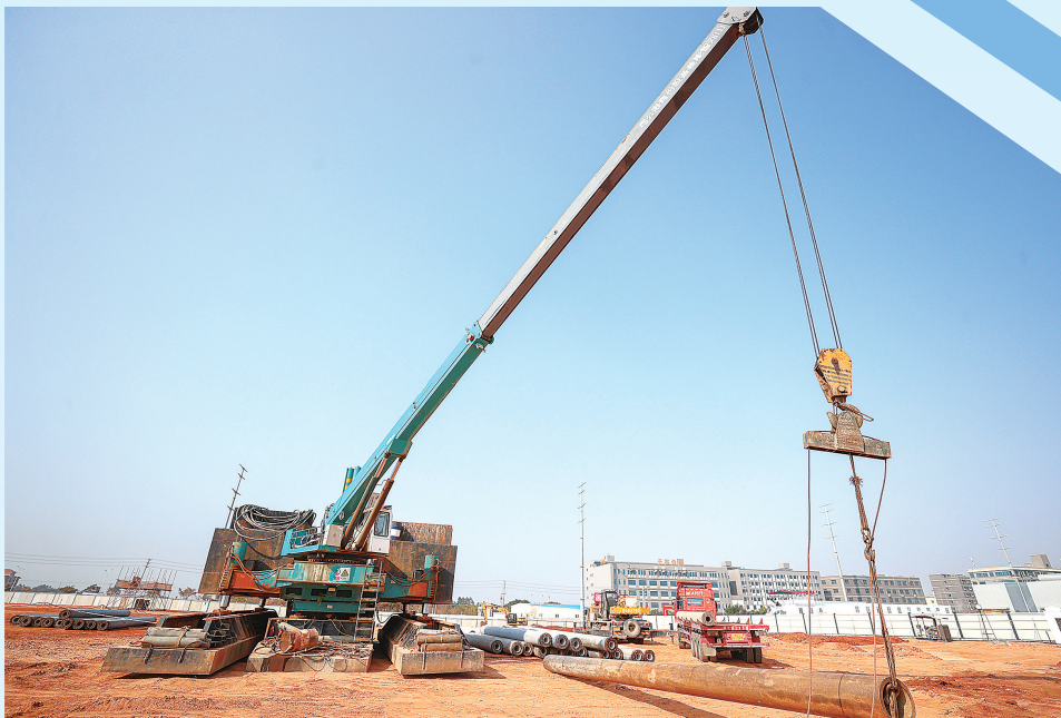
晋江金井绿色新材料产业园标准厂房项目(一期)
