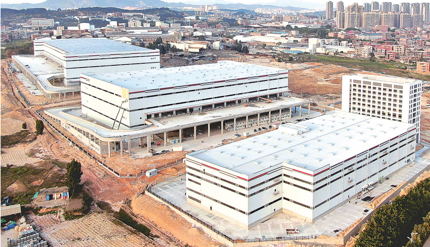
泉州顺丰创新产业园项目4栋主体大楼的外部装修已全面完工。本报记者 秦越 摄
