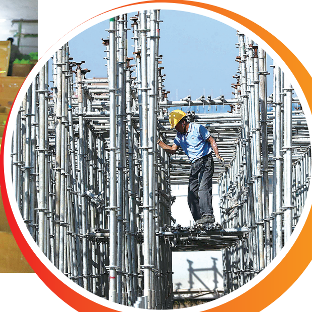
智能装备基地安海园内,工人们忙建设。
