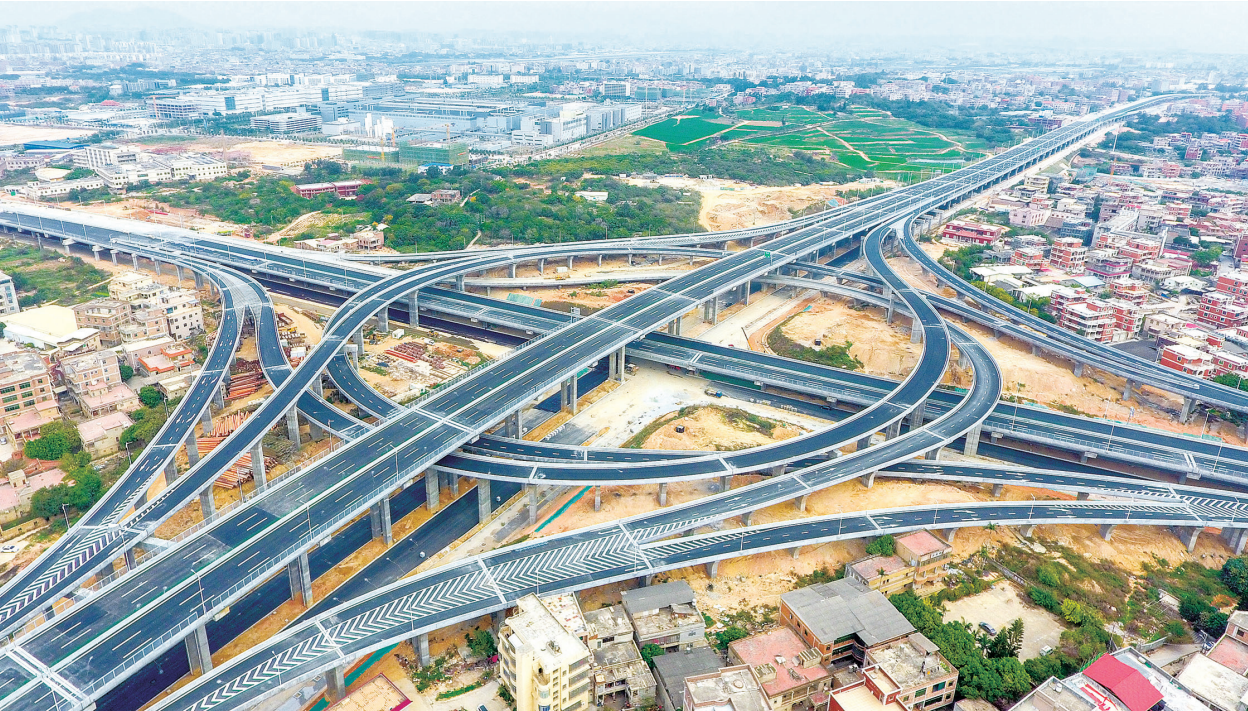
二重环湾快速路(晋江段)新建工程一期主线高架桥桥梁主体完工。 本报记者 董严军 摄
