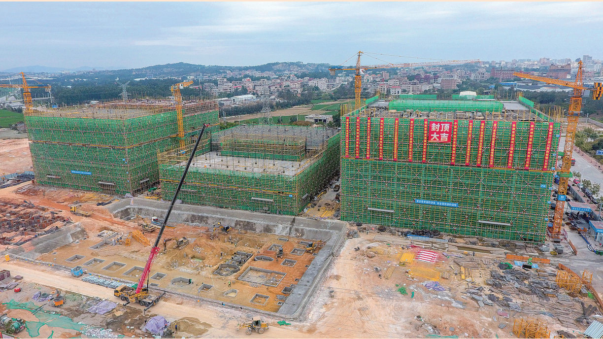
晋江经济开发区英林园现代服饰一体化标准厂房项目，首栋厂房主体结构封顶。本报记者 董严军 摄
