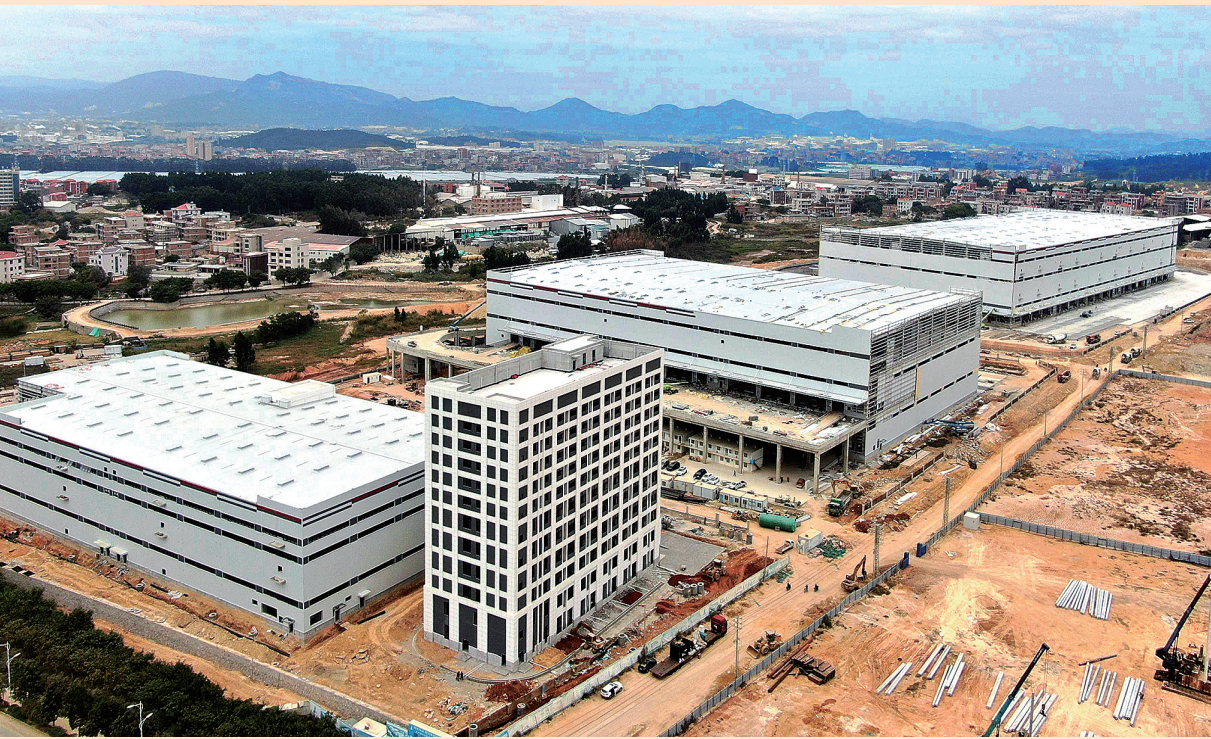
泉州顺丰创新产业园项目，4栋主体大楼的主体结构全部完工。本报记者 秦越 摄
