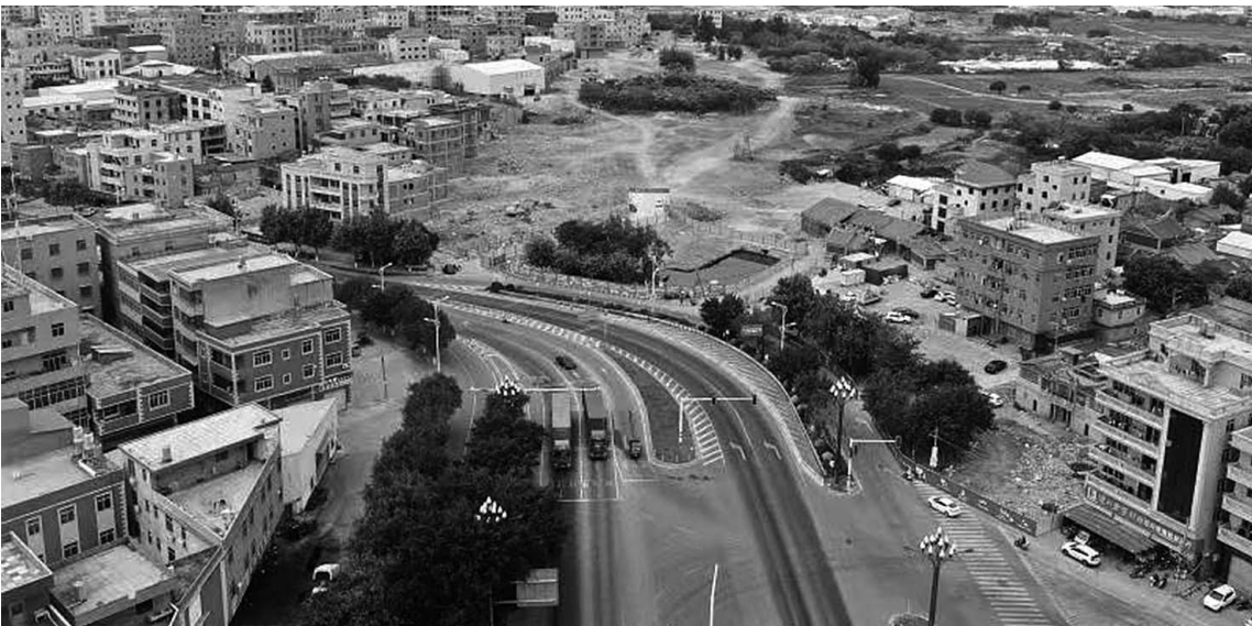
世纪大道南延伸项目正式转入实质建设阶段。
