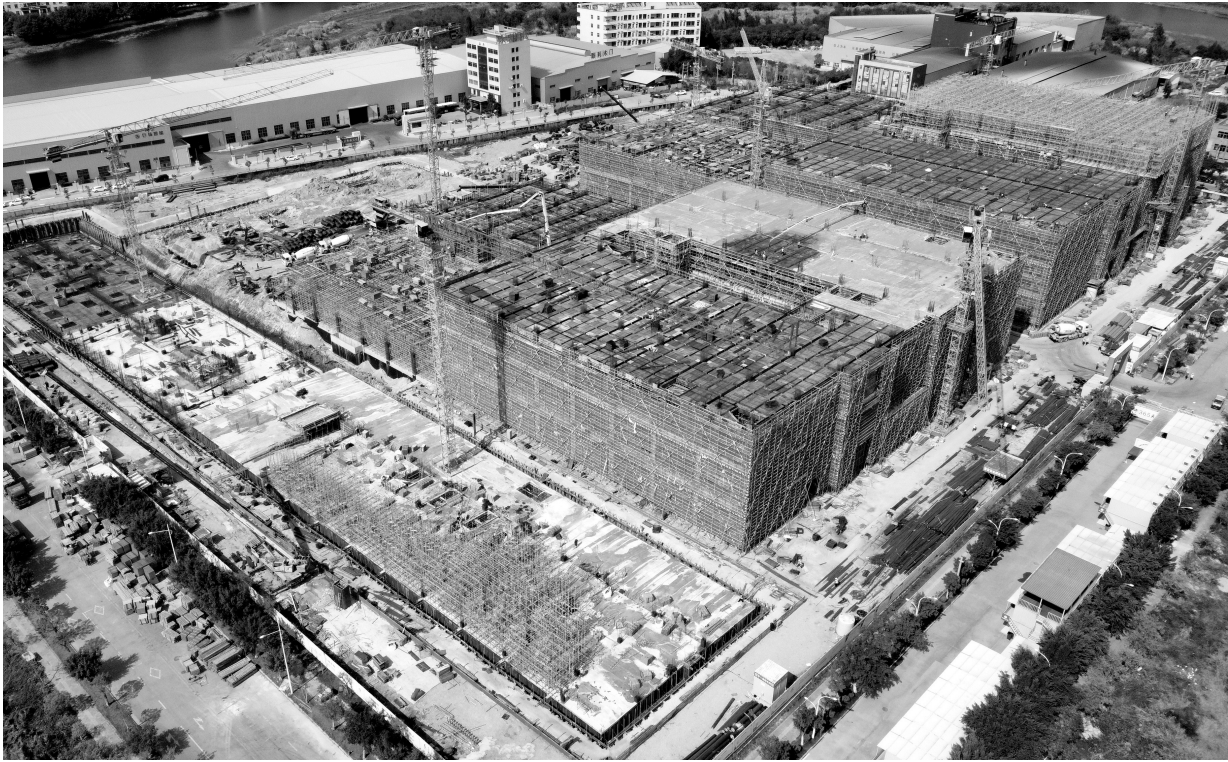
安东绿色高端面料整理微工业园
