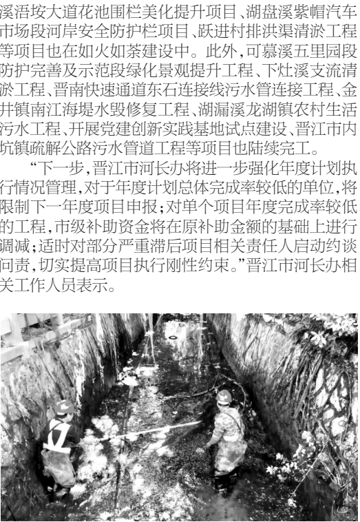
工人对河道进行清淤。
