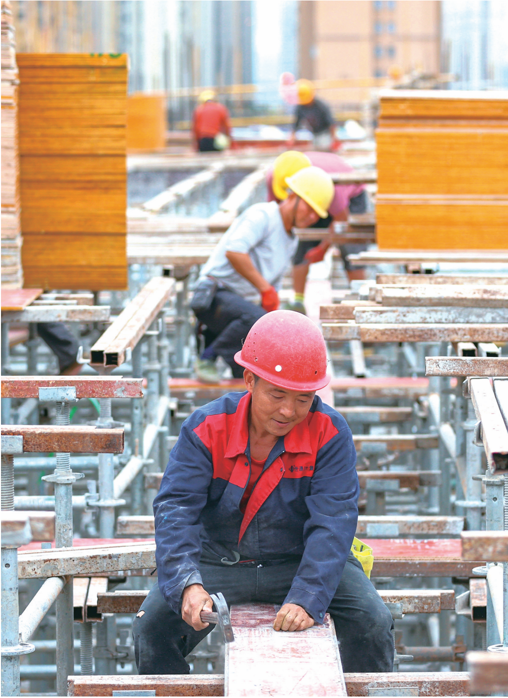
昨日,晋江市池店文教园(晋江一中池店校区)项目建设者全力以赴赶工期、抓进度,有序推进项目建设。该项目有望春节前全部封顶,预计2023年10月份竣工验收。
