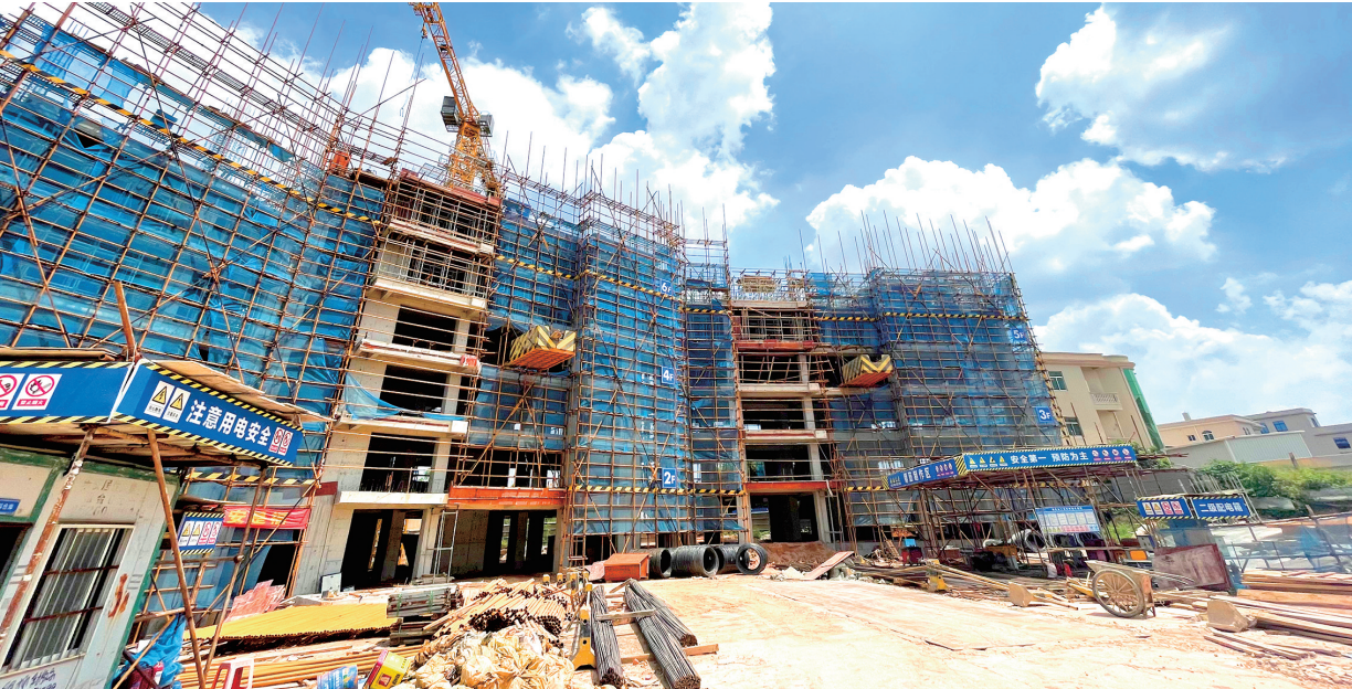
溪边旧村改造拆迁安置住宅小区项目建设现场。
