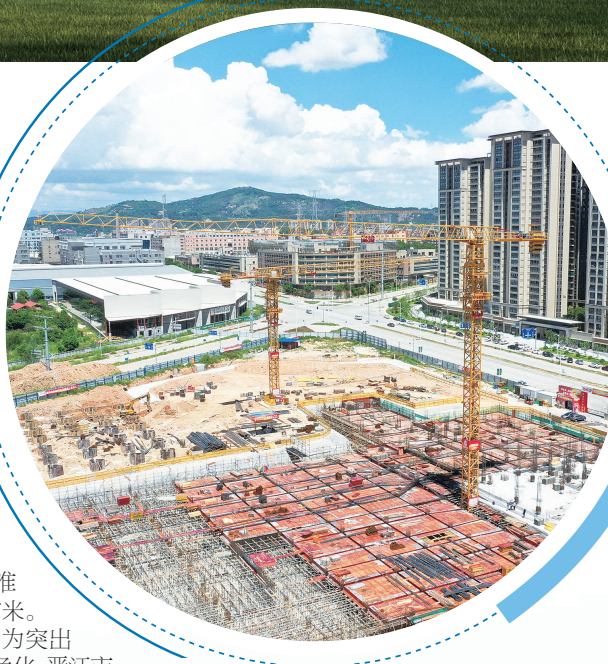
养正中学开发区校区项目现场。
