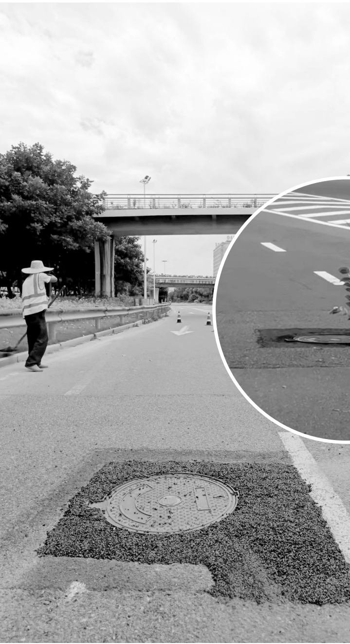
双龙路破损路面已修复。
