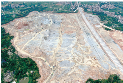
惠安县辋川镇小山区域土石方及环境修复工程项目。
