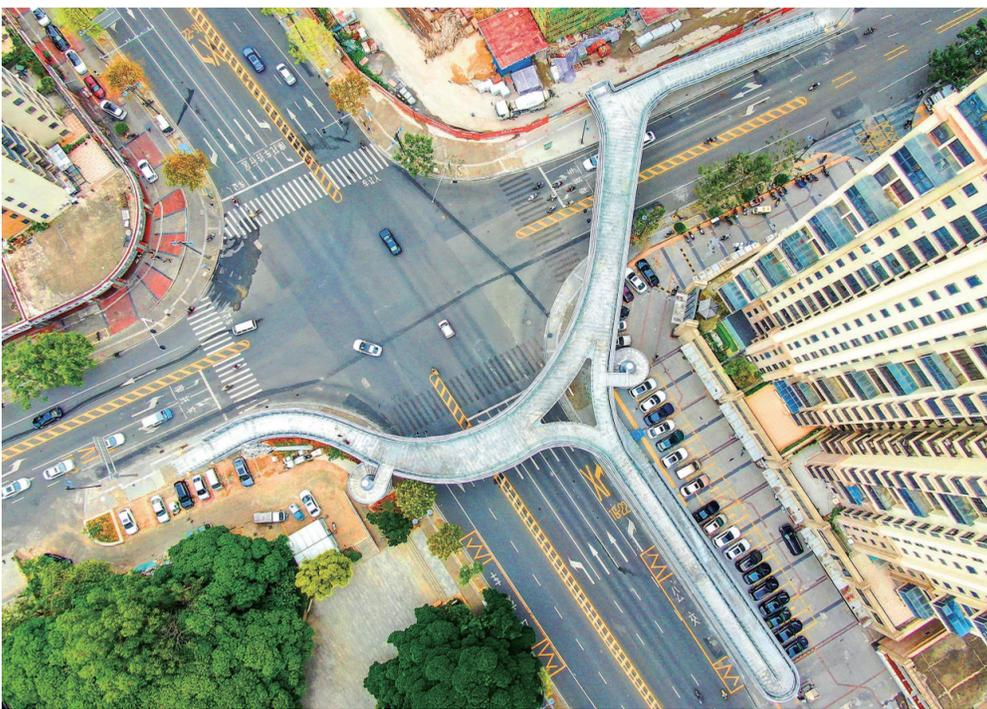
昨日,记者从晋江市交通运输局获悉,石鼓路-梅园路人行天桥正式通行。天桥总长349米,最大单跨跨度37米,整座天桥呈丝带状。
