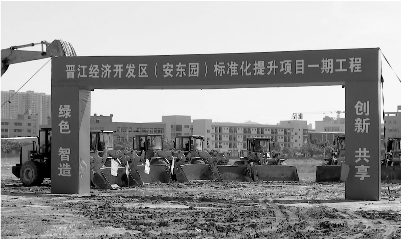
晉江經濟開發區（安東園）標準化提升項目一期工程17日開工。
