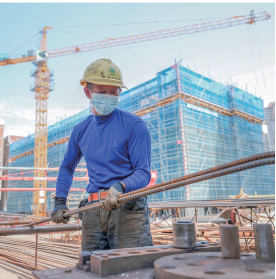
工人在绑扎钢筋。 本报记者 陈巧玲 摄
