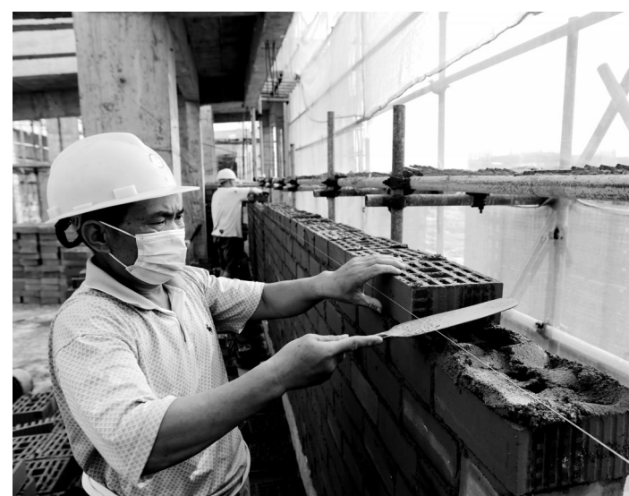
高鐵新區格瑞新苑安置房項目現場，工人正在砌牆。
