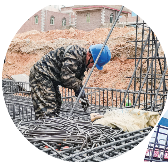
东部快速通道A1标作业现场
