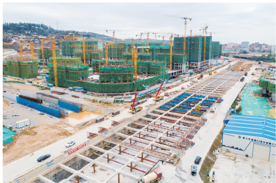
东部快速通道A2标主线隧道贯通
