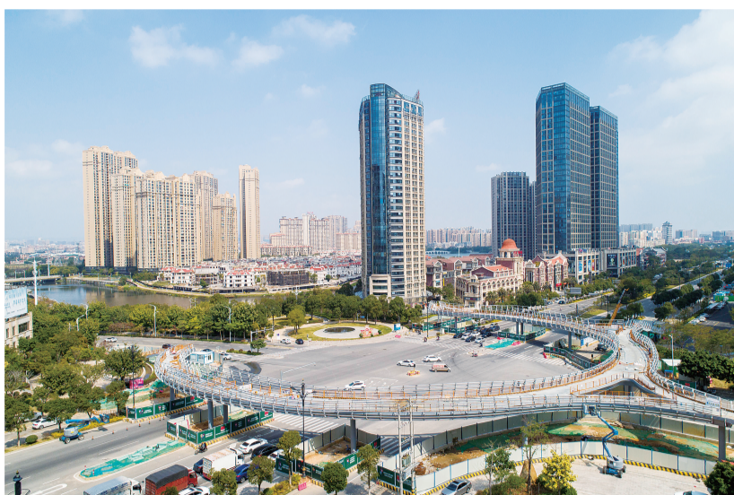
双龙路—晋宁路人行天桥工程
