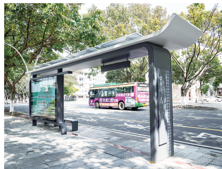
崇德路改建后的公交亭
