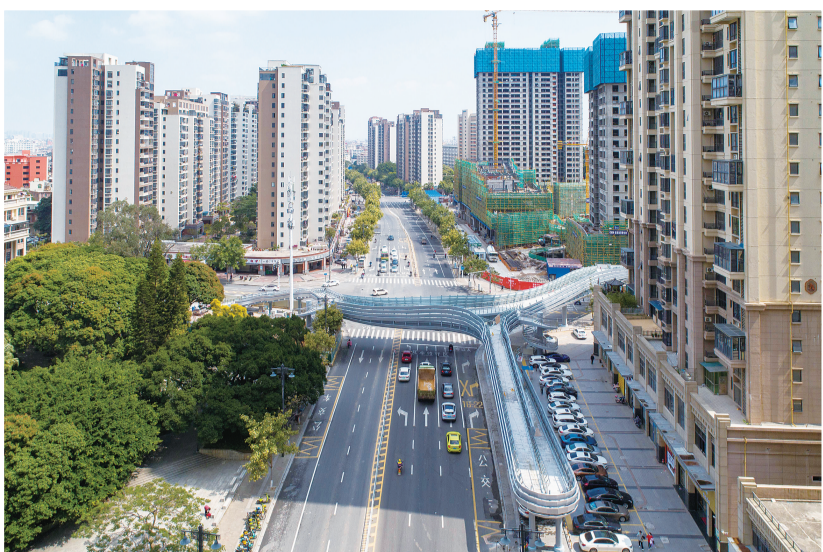
石鼓路—梅园路人行天桥工程
