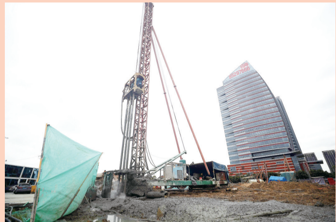
盛荣中心项目开工建设。
