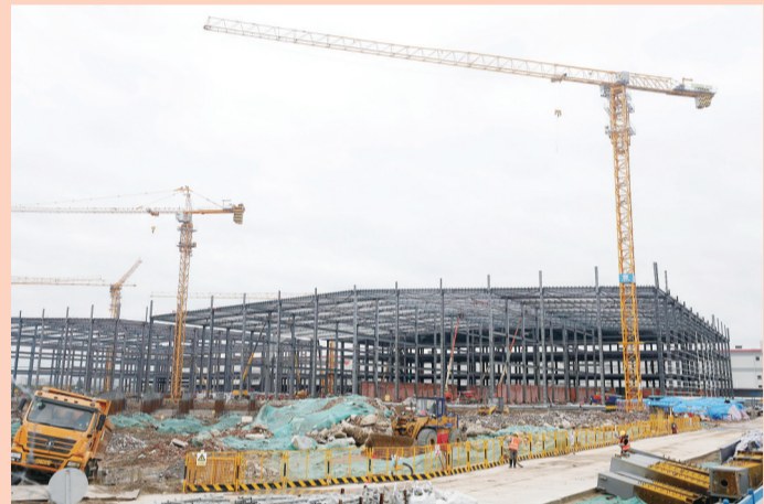
安踏一体化产业园物流园区二、三期项目加快建设。
