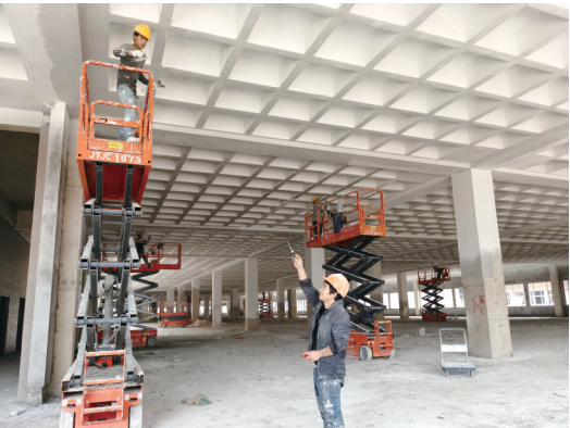
工人室内装修忙。
