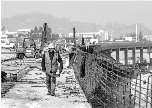
二重環灣快速路(晉江段)A1標段工人在施工。
