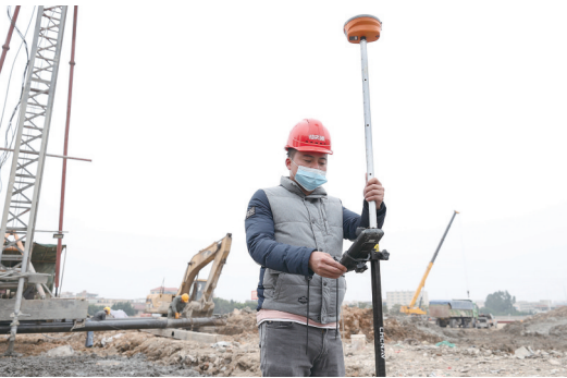
施工人员正在进行测量作业。
