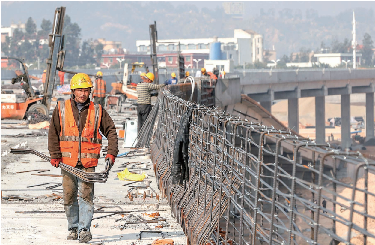
二重环湾快速路(晋江段)A1标段工人在施工。
