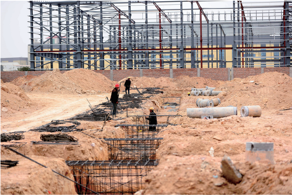
如火如荼的项目施工现场。
