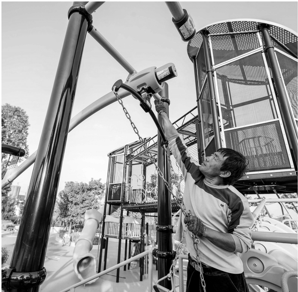
工人安裝游樂設施部件。
