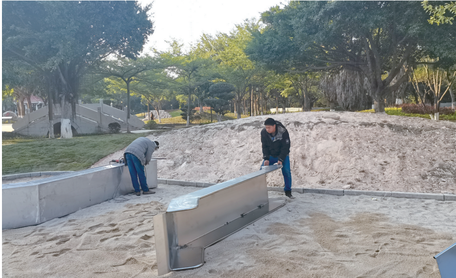
工人安装滑梯
