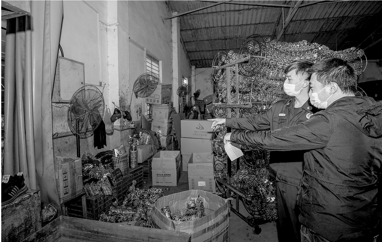
开发区一家工厂消防通道堆满货物。
