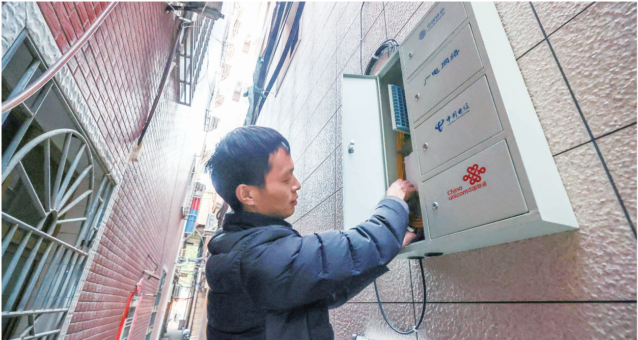
施工人员正将通信线缆接入“四网合一”光纤分纤箱。 本报记者 董严军 摄
