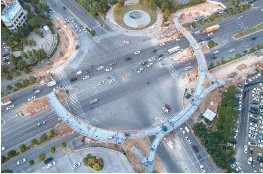
昨日,该环形天桥吊装已完成一半。
