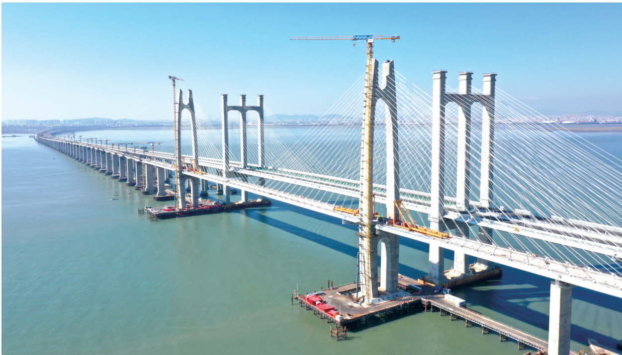
11月30日拍摄的新建福厦铁路泉州湾跨海大桥。新华社
