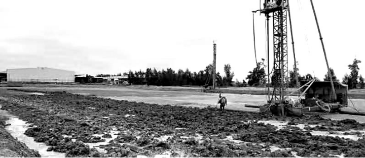
水泥攪拌樁正在施工。 本報記者 關楊娜 攝
