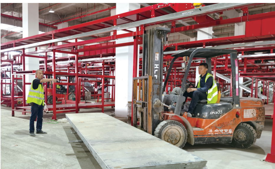
建设中的福建极免泉州转运中心。
