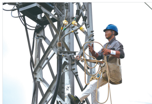
电力施工人员紧急抢修因台风造成的供电故障。通讯员 游劲松 本报记者 颜雅 摄
