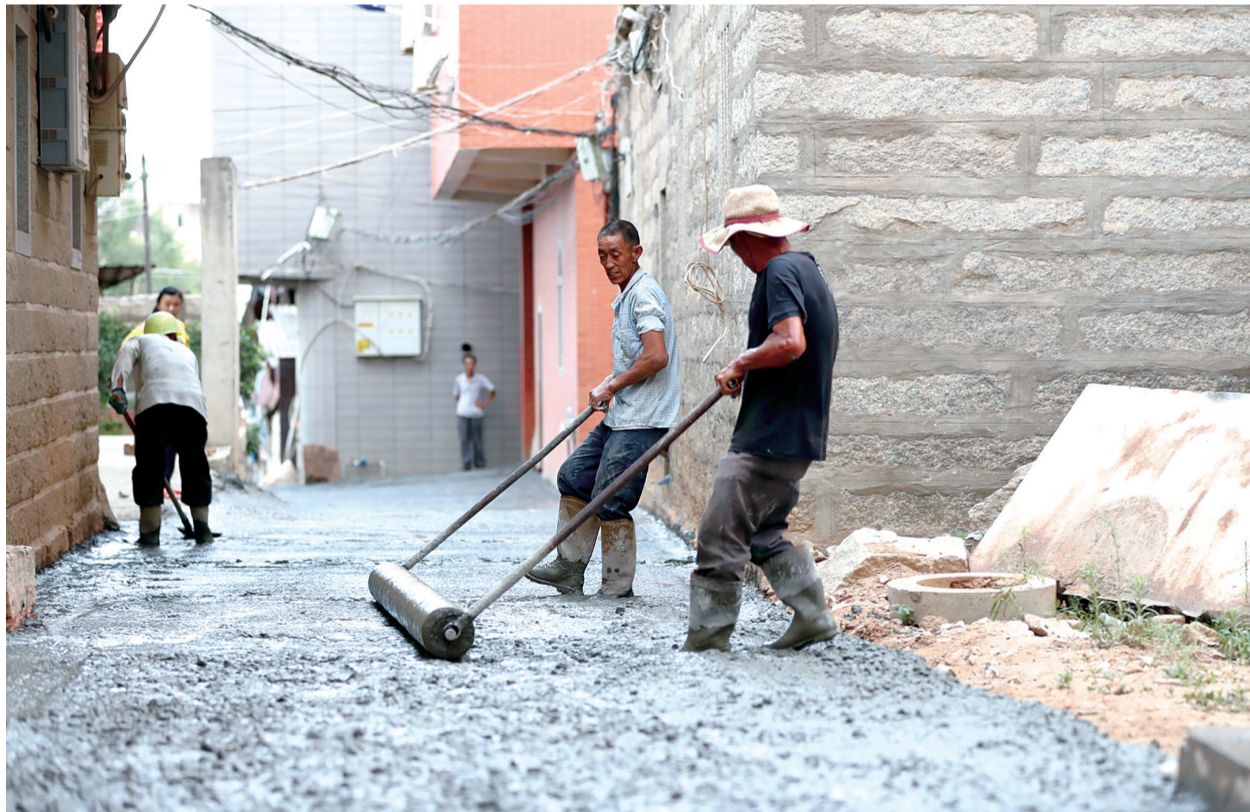
安海曾埭村内部道路改造提升现场。
