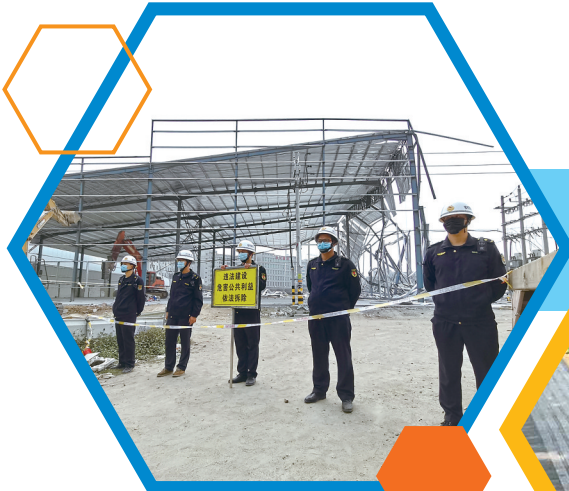
拆除违法搭盖。
