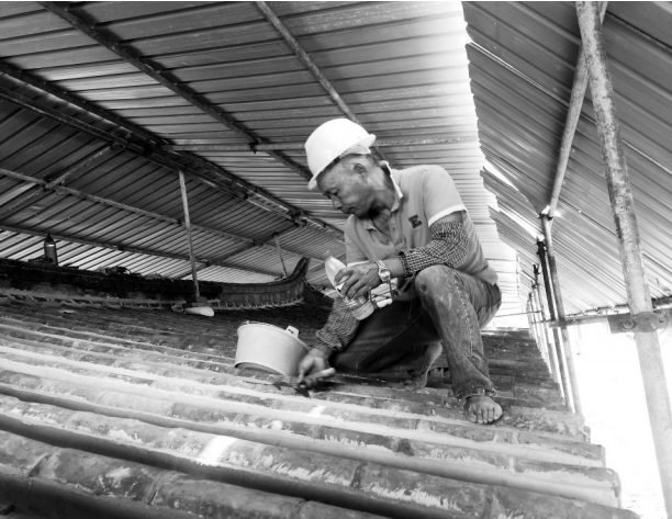
工人对屋顶进行勾缝处理。
